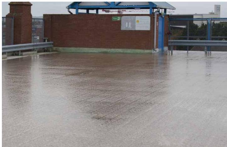
**Sikaguard® Decor** es un sello de concreto con base en resina acrílicas, con solventes.
