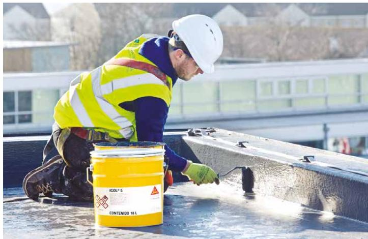
**Igol® S** es un impermeabilizante a base de asfalto diluido en solvente, mono componente, para impermeabilización de concreto, mampostería madera y para protección de elementos metálicos bajo tierra.
