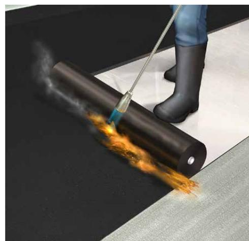
**Sika® Lámina Asfáltica Aluminio**, es un producto prefabricado a base de asfalto modificado con polímeros y estructurada con polietileno y autoprotégida en la cara expuesta con una película de aluminio con alta resistencia a los rayos UV y gran flexibilidad.
