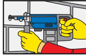
Perfore el orificio con un taladro eléctrico al diámetro y profundidad requeridos. El diámetro del orificio de perforación debe estar de acuerdo con el tamaño del anclaje.
