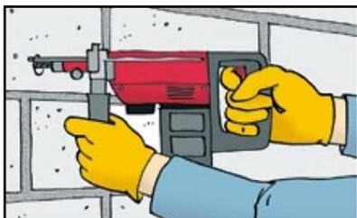
1. Realice la perforación con un taladro con el diámetro y profundidad deseados. El diámetro de la perforación debe ser de acuerdo al tamaño del anclaje para evitar desperdicios.
