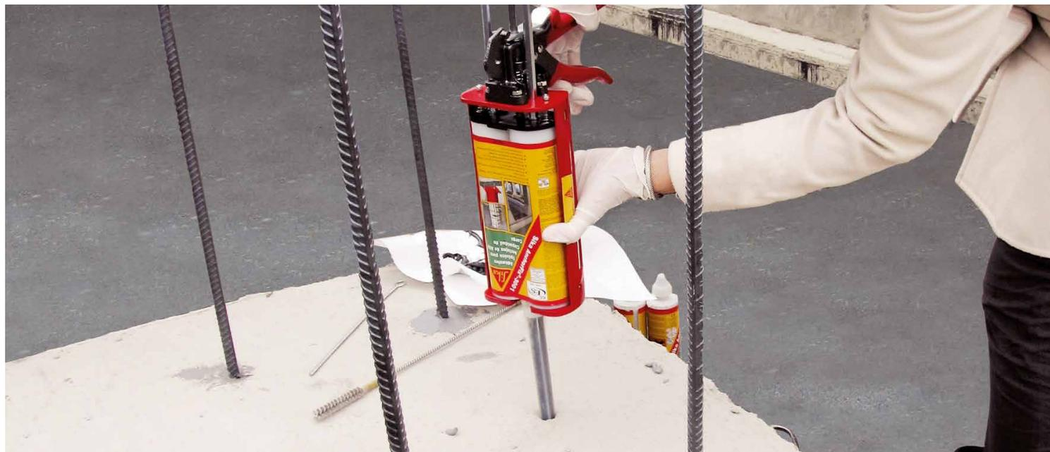
**Sika Anchorfix®-3001**, Nuevo adhesivo epóxico especialmente formulado como un sistema de dos componentes, de alto desempeño para anclajes de pernos roscados y barras corrugadas, en concreto fisurado y no fisurado.
