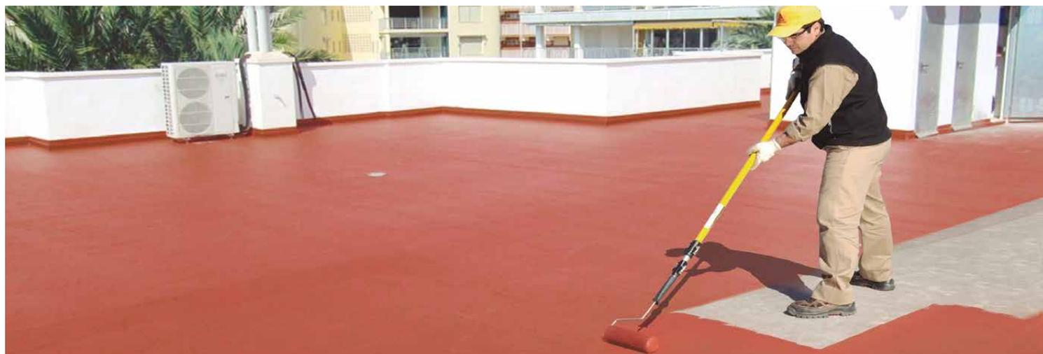
**SikaFill®** Es una emulsión acrílica para la impermeabilización flexible de cubiertas en techos y terrazas transitables, que no requiere pintura reflectivas como acabado, y que una vez seco, forma una película flexible, impermeable y duradera.
